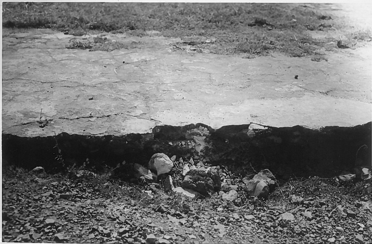
RAVINEMENT BORDURE SEUIL DE PISTE N° 32 AVEC TRACES D'IMPACT ROUE DROITE AU CENTRE.
