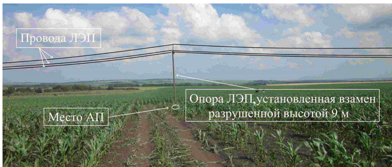
Рис. 9. Провода ЛЭП в районе н. п. Кистенево (над обрабатываемым полем)
