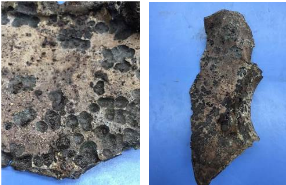
Figura 7. Fragmento del case del PGB izquierdo, luego de su limpieza y preservación. Deterioro por corrosión por picado
