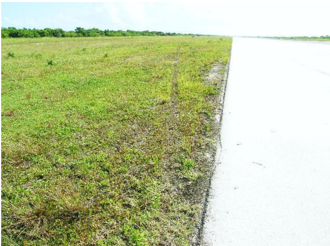
Marcación del neumático donde la aeronave sale de la pista.
