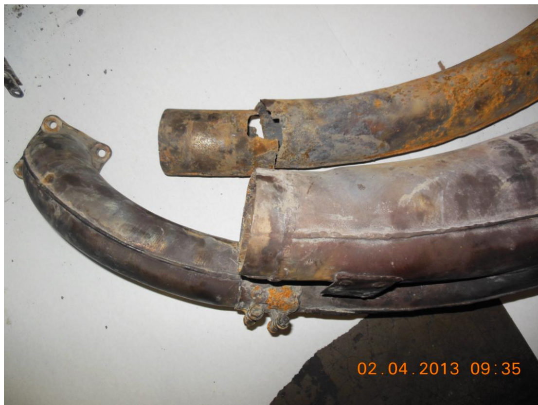
Рис.16 Разрушение жаровой трубы выхлопного коллектора
