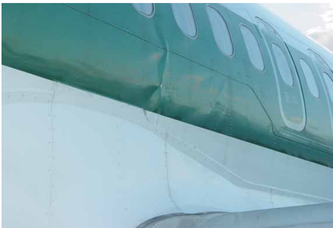
Deformazioni sul lato sinistro della fusoliera dell'a/m I-DAWR.
