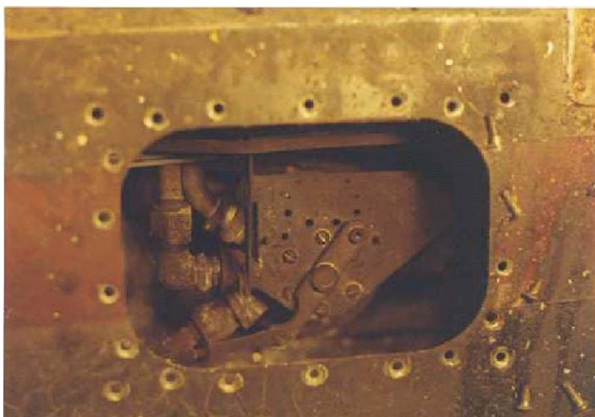
Válvula selectora esquerda de combustível, antes de ser retirada do avião, na posição OFF.
