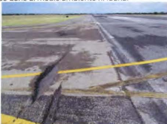
1.4.1. daño ocasionado al golpear el motor número uno
