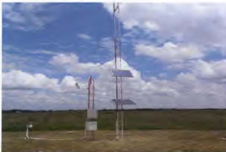
1.7.2. Equipo de captura y transmisión de datos meteorológicos marca Campbell ubicado a 315 m del umbral de la pista 21
